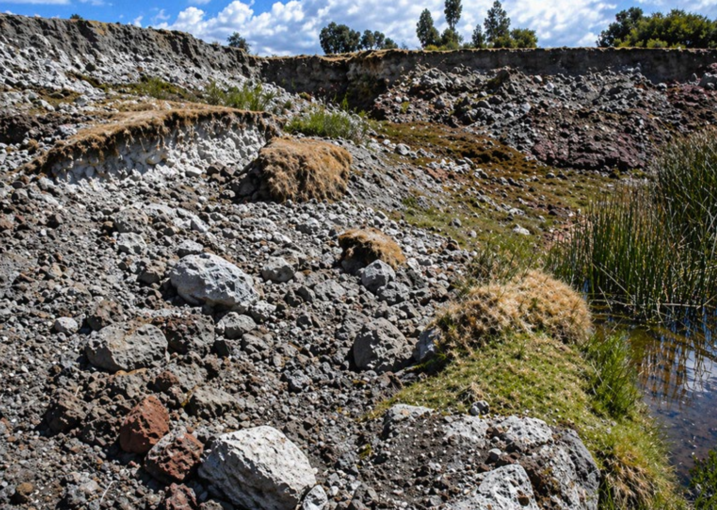
Deslizamiento de tierras en el sector de Pongobamba (2000). Fuente: Archivo MIMA.
