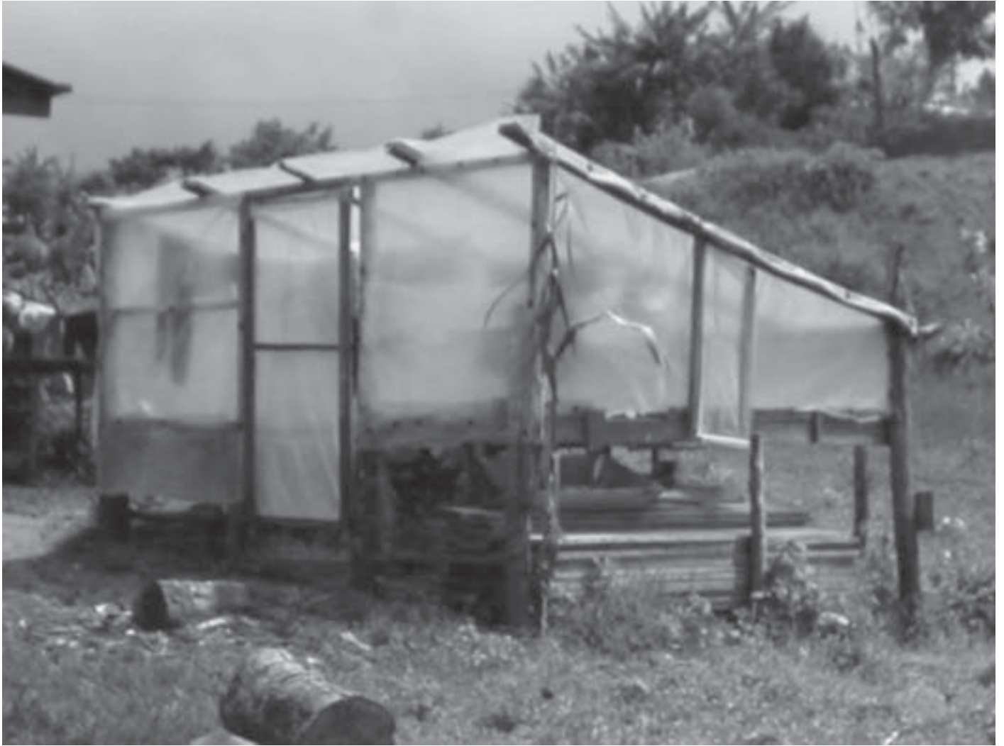
Construcción del primer modelo de secador solar
