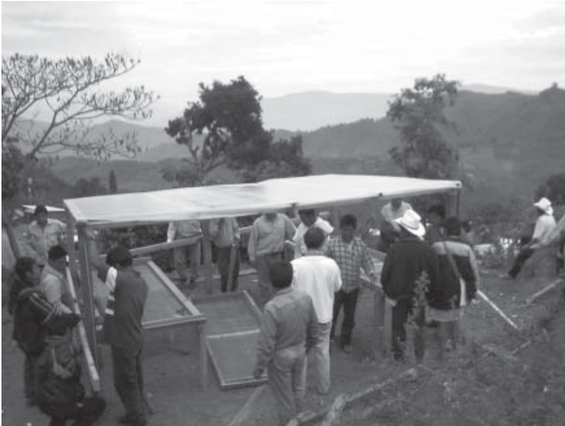
Construcción de secadores solares para café
