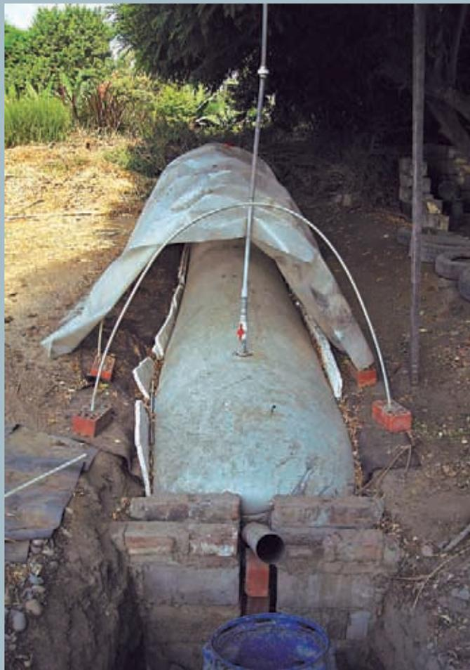
Biodigestor de geomembrana 📷 T. Gianella
