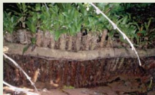
Es una interesante experiencia de manejo de cuencas para la prevención de desastres por inundación, evitando la erosión de suelos por formación de cárcavas y deslaves. Propicia el uso de técnicas de posible adaptación por los agricultores: presas filtrantes (usando roca y vegetales locales) Según el artículo. Los agricultores han innovado las técnicas recibidas como transferencia de tecnología.
