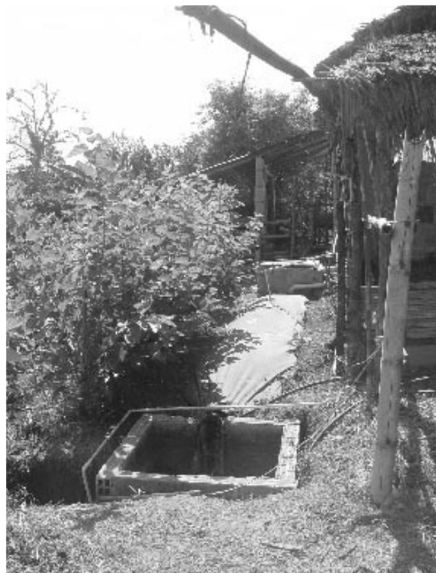
Biodigestor fabricado con una manga de lámina de polietileno de 1,2 m de diámetro por 6 m de largo, conectado a un corral de cerdos con 20 animales y cercado con moreras. Finca Ecológica Tosoly, Fundación Universidad de Agricultura Tropical (UTA Foundation), Guapotá, Santander, Colombia
